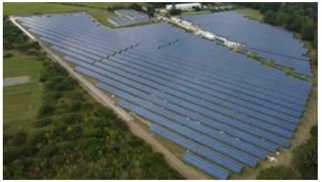
Ainsi, en 2022, ZE ENERGY a mis en service son premier projet de centrale hybride solaire + stockage (8MW de PV et 4MW de stockage) de France continentale à Mennetou-sur-Cher (Loir-et-Cher). Equipée de batteries lithium-ion permettant de stocker l'énergie solaire produite dans la journée, la centrale permet de répondre au défi posé par l'énergie solaire : son intermittence.
